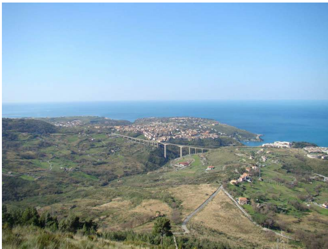
Aree in frana loc. Pietrascivola sinist.. Idrogr. – Loc. Vannefora Destr. Idrog. -Torrente Calgrande
